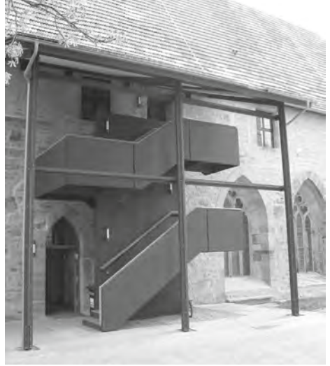
Der neue Treppenaufgang Foto: Architekturbüro Smits+Tandler
