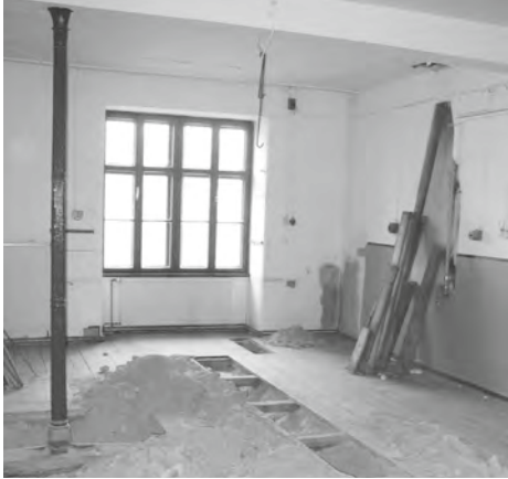
Saal während der Bauarbeiten
