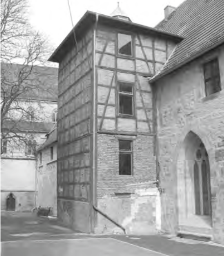
Das alte Treppenhaus vor dem Umbau Foto: Architekturbüro Smits+Tandler
